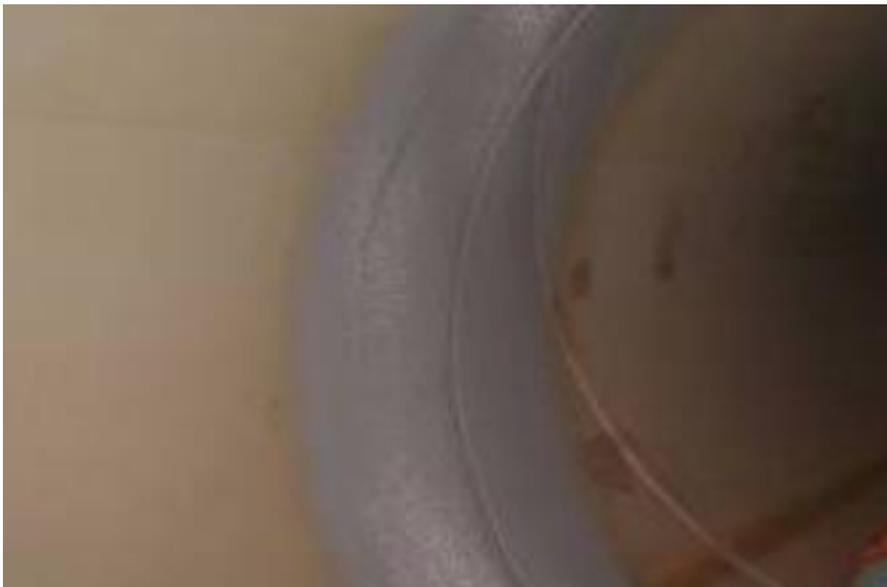
管段内焊缝无溶剂涂料补口：使用双组份无溶剂类涂料进行一次性补口成型，补口前应对所选用的涂料进行试喷涂，并准确测出干膜和湿膜厚度的比值，根据项目补口厚度要求，一次喷涂成型，补口幅度的设定，考虑到定位的精确度，涂层的补口幅度应超出表面处理两边量为25mm，即每个焊缝涂敷总幅度（宽度）为150mm。
