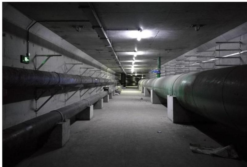
补口工作是从管段的最远端开始，依次完成每道焊口的表面处理和涂层补口作业。安装单位现场组对焊接成管段，每个管段允许最大焊口数为40个（补口车的一次有效补口距离范围内）
