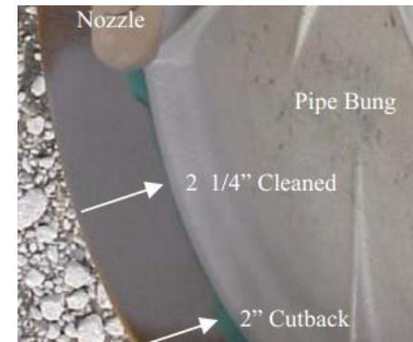
在焊接前，对内防腐钢管在防腐预制时两端的预留段（距管 $70\pm 10\text{mm}$ ）进行喷砂除锈，要求质量达到Sa2.5级的标准；并彻底清理遗留在管道内的磨料和表面的浮尘。喷砂除锈质量合格后，涂刷 $20\mu\text{m}$ 左右厚的可焊性涂料，以阻止经喷砂处理后的表面在焊缝补口前再次生锈，如果在单根钢管防腐预制时管端涂刷了可焊性保护涂料，安装前管端没有再出现锈蚀情况时，可省掉该表面处理工序。涂层厚度宜薄但要均匀，不得有流挂等现象产生。
